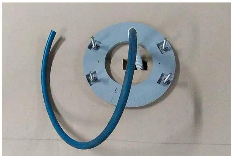
Eliminare il Tappo centrale della Calotta ed inserirla sulle Zanche nel verso indicato inserendo il Cavo di alimentazione nel foro centrale (Esempio a 5 poli - Vedi anche Appendice B).
